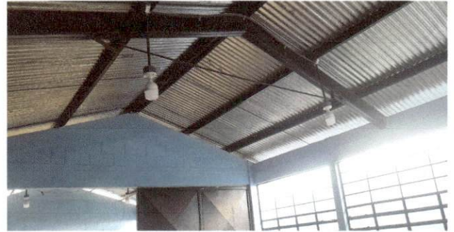
Foto 4: Reparacion del sistema electrico
