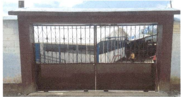
Foto 2: Mejoramiento e instalación de Porton
